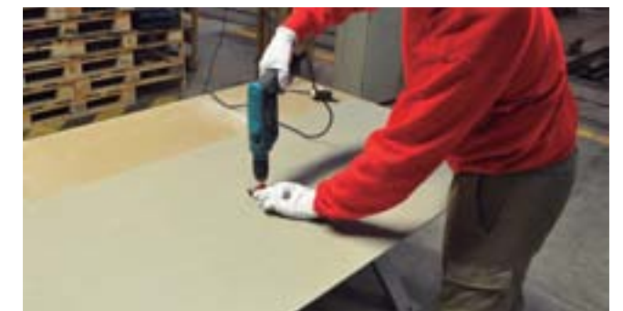
ES Se aconseja redondear el ángulo interno realizando previamente un orificio con un taladro y una broca adecuada para porcelánico (refrigerada con agua).
