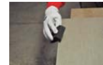
Für eine optimale Ausführung muss der Rand der Keramikplatte mit einem Diamantschwamm abgeschliffen werden. Immer von oben nach unten verwenden, nie seitlich.
