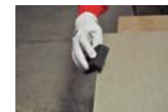
Для получения оптимальной отделки отшлифуйте край керамической плиты мочалкой с алмазной поверхностью. При этом всегда водите мочалкой сверху вниз, и никогда вбок.
