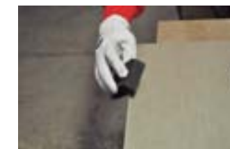
Für eine optimale Ausführung muss der Rand der Keramikplatte mit einem Diamantschwamm abgeschliffen werden. Immer von oben nach unten verwenden, nie seitlich.
