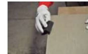
Für eine optimale Ausführung muss der Rand der Keramikplatte mit einem Diamantschwamm abgeschliffen werden. Immer von oben nach unten verwenden, nie seitlich.
